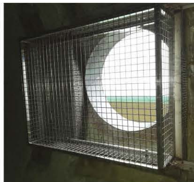
提篮格栅安装完毕
