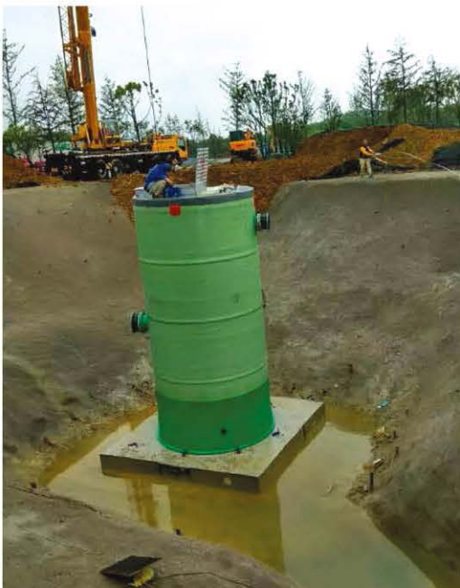
河道提水泵站
